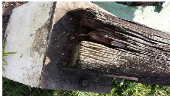
Figura 1 – Apodrecimento da base de um pilar inclinado.
