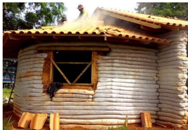
FIGURA 02: Construção em superadobe
