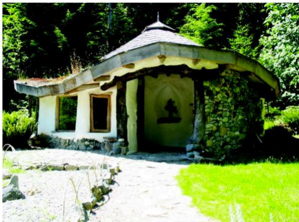
FIGURA 01: Construção em COB.
