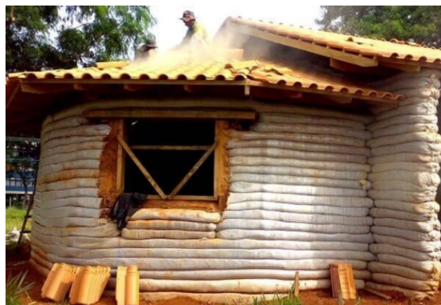
FIGURA 02: Construção em superadobe
