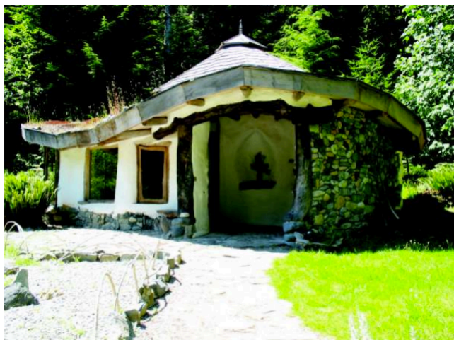
FIGURA 01: Construção em COB.
