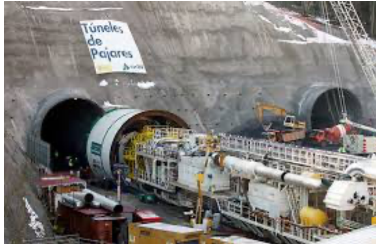
Figura 1 – Construção de um túnel por escavação por coraça mecânica
