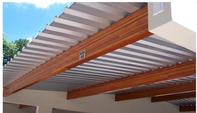
**Figura 01** – Exemplo de viga de madeira lamelada colada.
