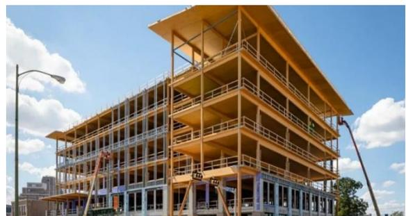
**Figura 02** – Exemplo de laje de madeira lamelada colada cruzada.
