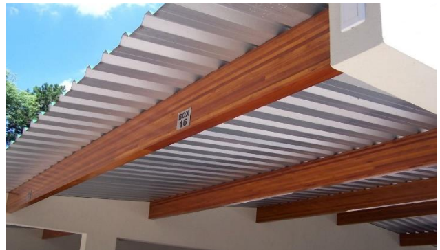
Figura 01 – Exemplo de viga de madeira lamelada colada.
